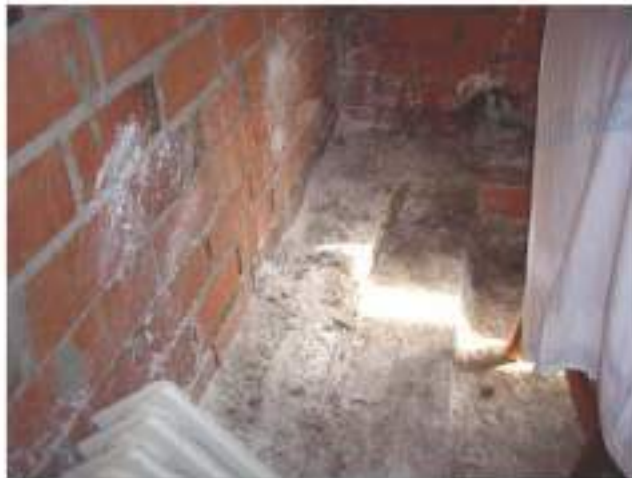
Fotografía 5. Detalle de zapata rectangular de 2,40 x 2,10 m con el vuelo por encima del nivel de solera de semisótano.
