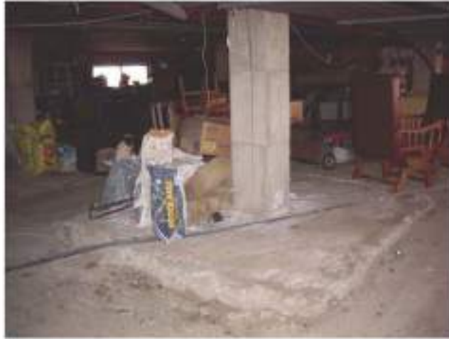
Fotografía 5. Detalle de zapata rectangular de 2,40 x 2,10 m con el vuelo por encima del nivel de solera de semisótano.
